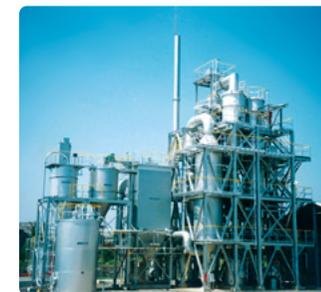
汚泥焼却高速流動床炉
